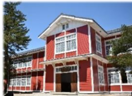
旧長井小学校第一校舎
